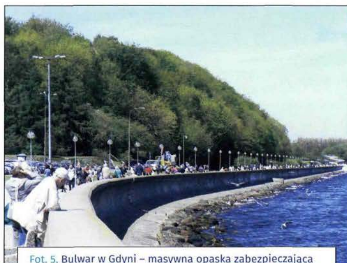
Fot. 4b. Bezpieczny profil brzegu
