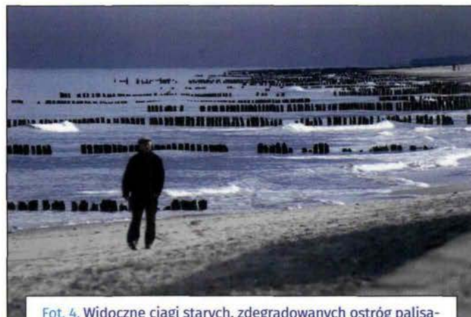
Fot. 4. Widoczne ciągi starych, zdegradowanych ostróg palisadowych w okolicy Władysławowa, 2009 r. (fot. P. Szymkiewicz)
