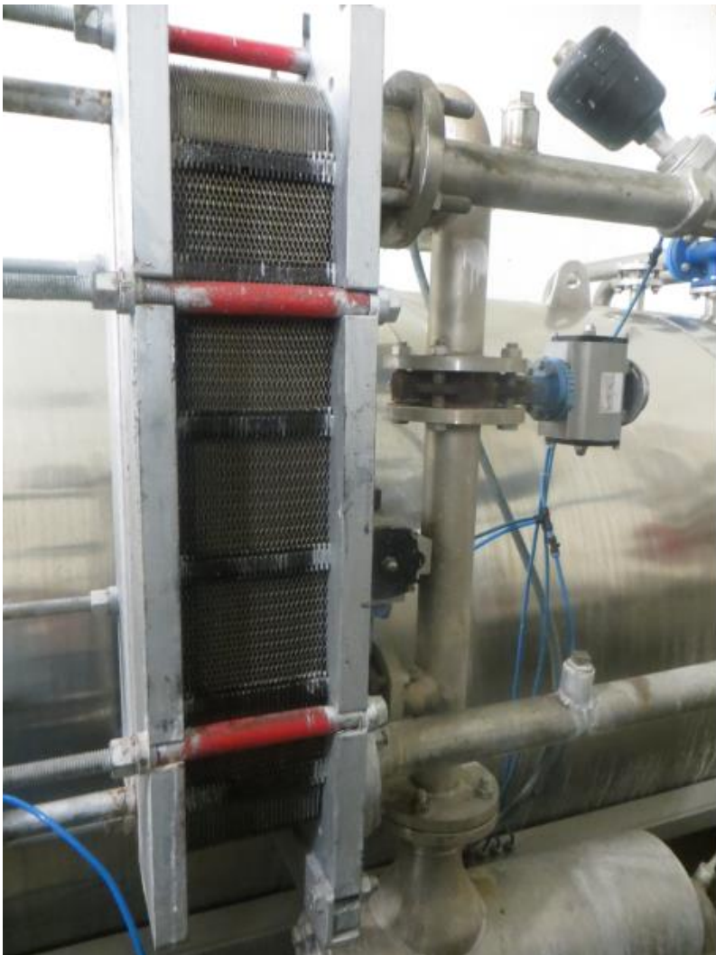
Zdjęcie 6. Płytowy wymiennik ciepła [źródło własne]
